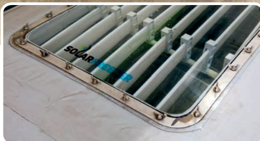
De lamellen in de bufferzak fungeren als warmtewisselaar.
